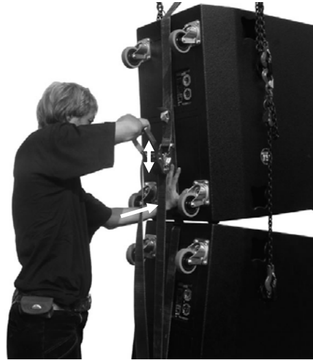
Zurren durch Ratschenbetätigung
